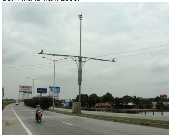
Tuyến đường Pháp Vân - Ninh Bình thuộc Quốc lộ 1A cũng đã được lắp đặt các camera giám sát
