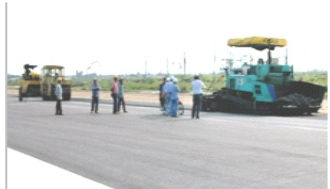
TVGS thi công bê tông nhựa polime đường hạ, cát cánh Cảng hàng không Cần Thơ
