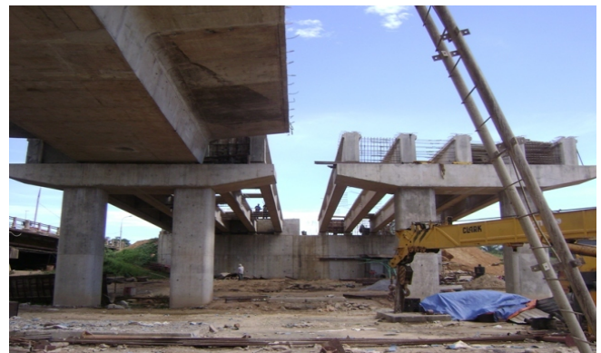
TVGS cầu Đò - Dự án nâng cấp, cải tạo QL1A
