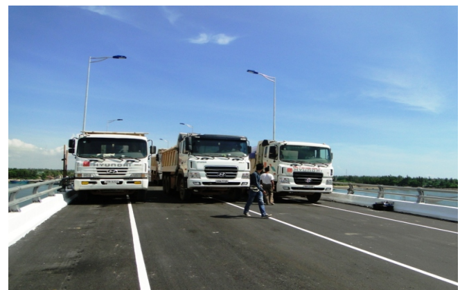
Thử tải cầu
